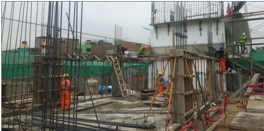
Figura N° 28: Acero y encofrado Horizontal (Fuente Propia).
