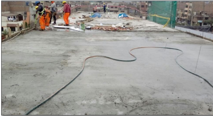
Figura N° 22: Vaciado de techo ultimo nivel - bloque D1 de Datos. (Fuente Propia).
