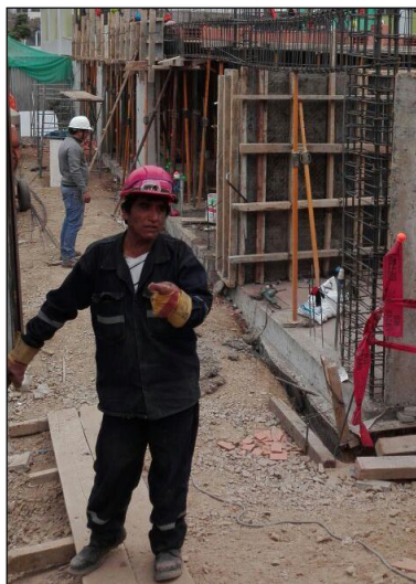
Figura N° 7: Esperas en el trabajo. (Fuente Propia).
