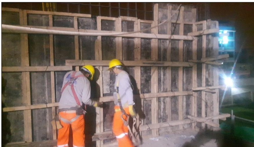
Figura N° 5: Encofrado de Placas. (Fuente Propia).
