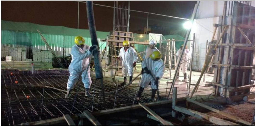
Figura N° 27: Vaciado elementos verticales. (Fuente Propia).
