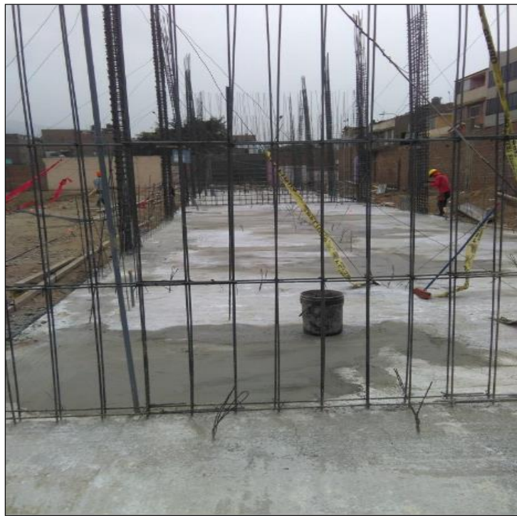
Figura N° 21: Inicio de acero vertical - bloque D1 de Datos. (Fuente Propia).
