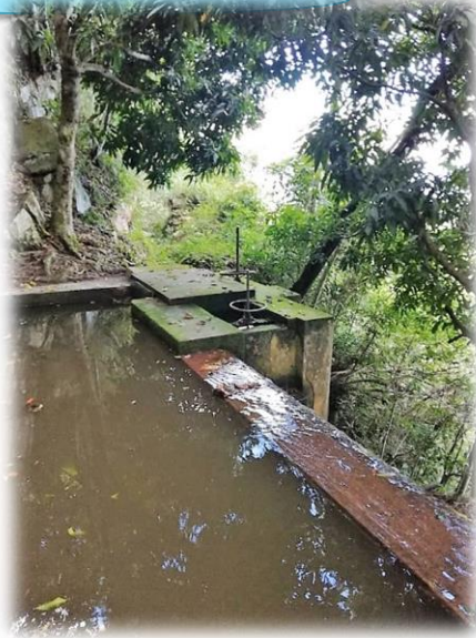
Imagen N°01: Vista de la estructura de la Cámara de reunión
