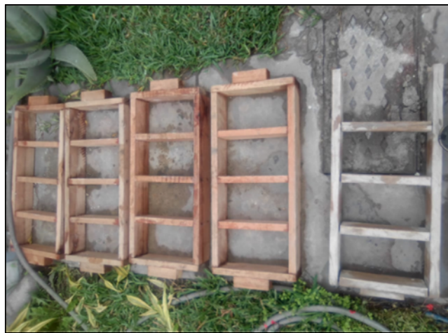
Figura 12. Fabricación de moldes de madera
