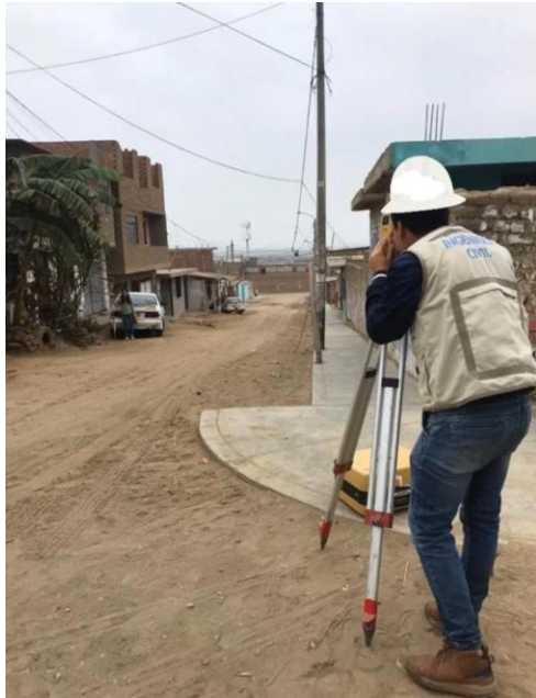
Levantamiento Topográfico – Punto N°4 en el sector bajo del centro poblado
