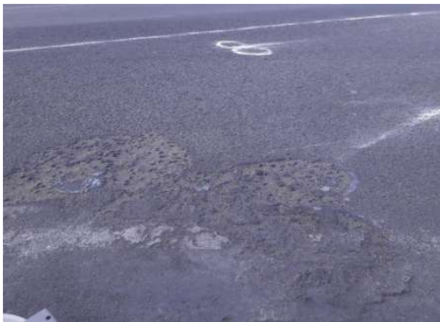
GRÁFICO N° 4: TOMA DE MUESTRA DESPRENDIMIENTOS DE AGREGADO
