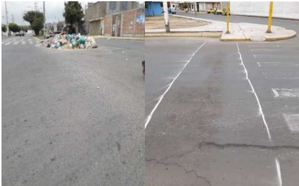
GRÁFICO N° 9: TOMA DE MUESTRA CORRUGACIÓN
