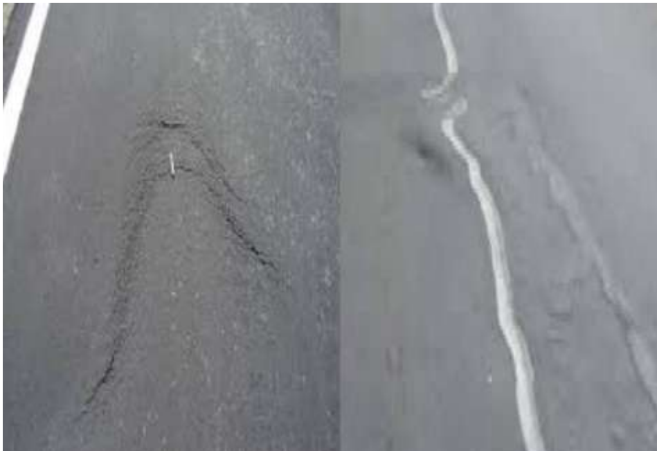
GRÁFICO N° 13: TOMA DE MUESTRA ABULTAMIENTOS Y HUNDIMIENTOS
