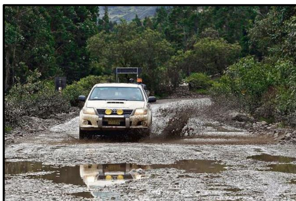
Figura 3: Vías sin asfaltar de la Red departamental
