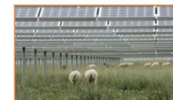
Granja solar de generación
