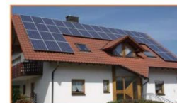
Aislada sistema solar casero
