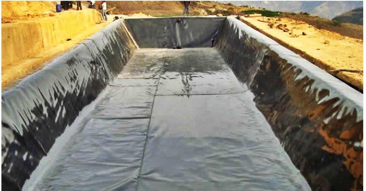
Figura 6.- Ejemplo de instalación de geomembrana.
