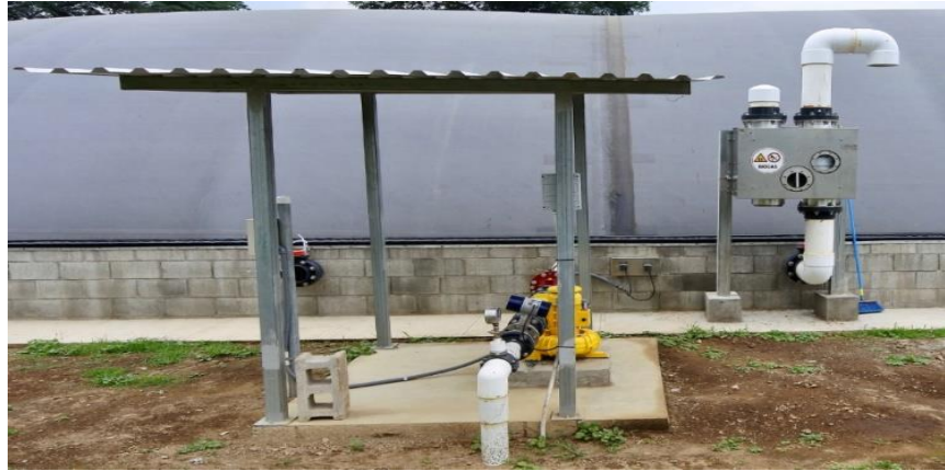
Figura 11.- Ejemplo de instalación de accesorios para biodigestor tipo laguna.
