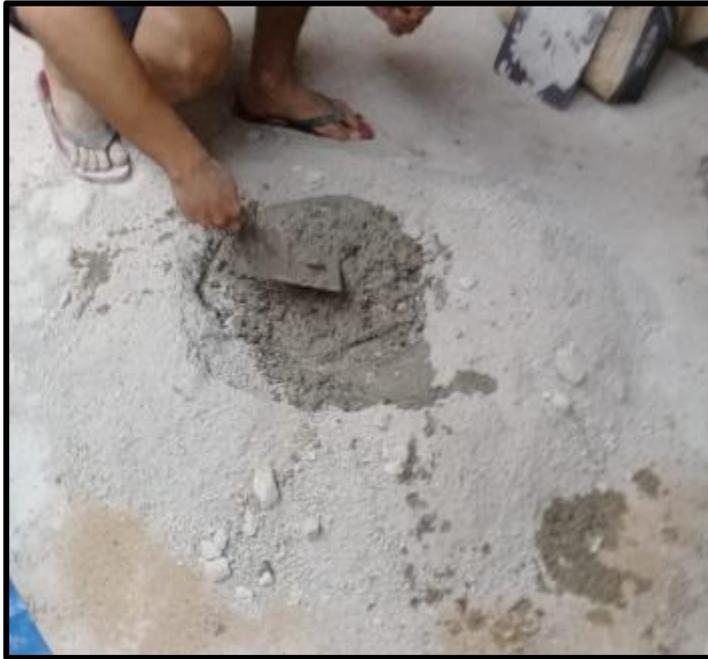
Figura 48. Mezcla de los materiales con el agua
