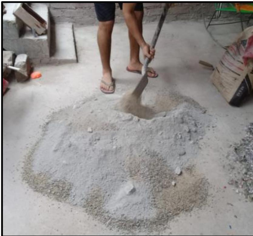
Figura 47. Preparación de la mezcla en seco.
