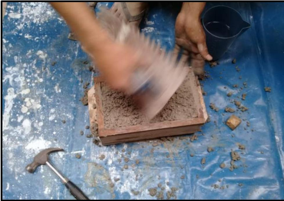
Figura 50. Proceso de compactado de ladrillo para su uniformidad.
