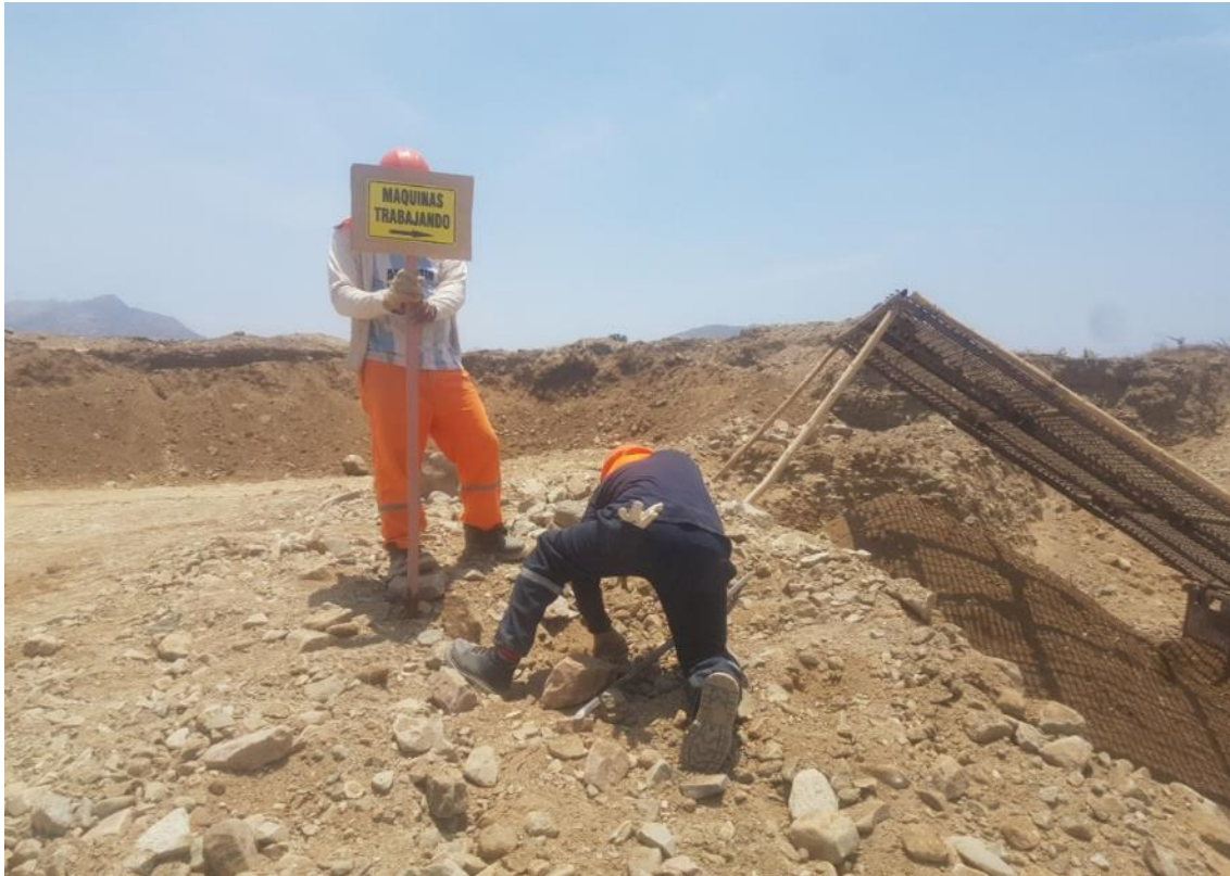
Figura 7: Señalización de la cantera R.B, Ferreñafe.
