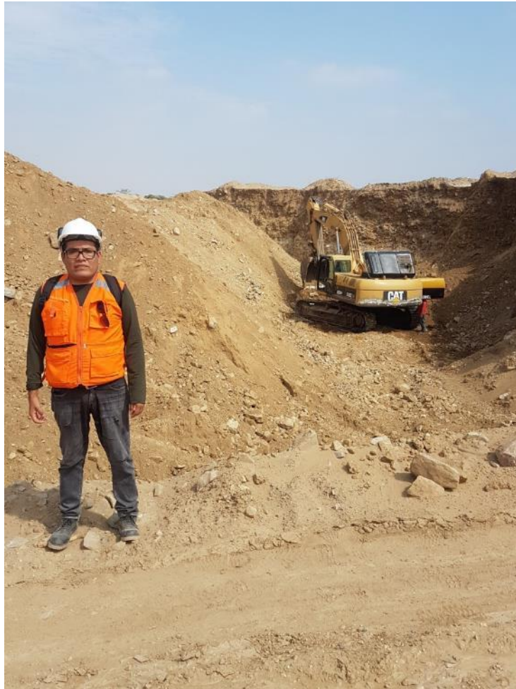
Figura 3: Arranque de material pétreo con la excavadora 330CL.
