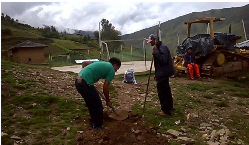
Figura N° 8. Cubriendo las calicatas
