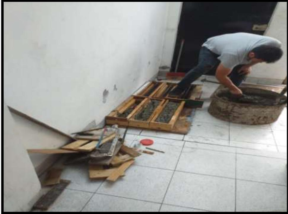
**Fotografía 03:** *Vaciado del concreto en los moldes de las Viguetas.*
