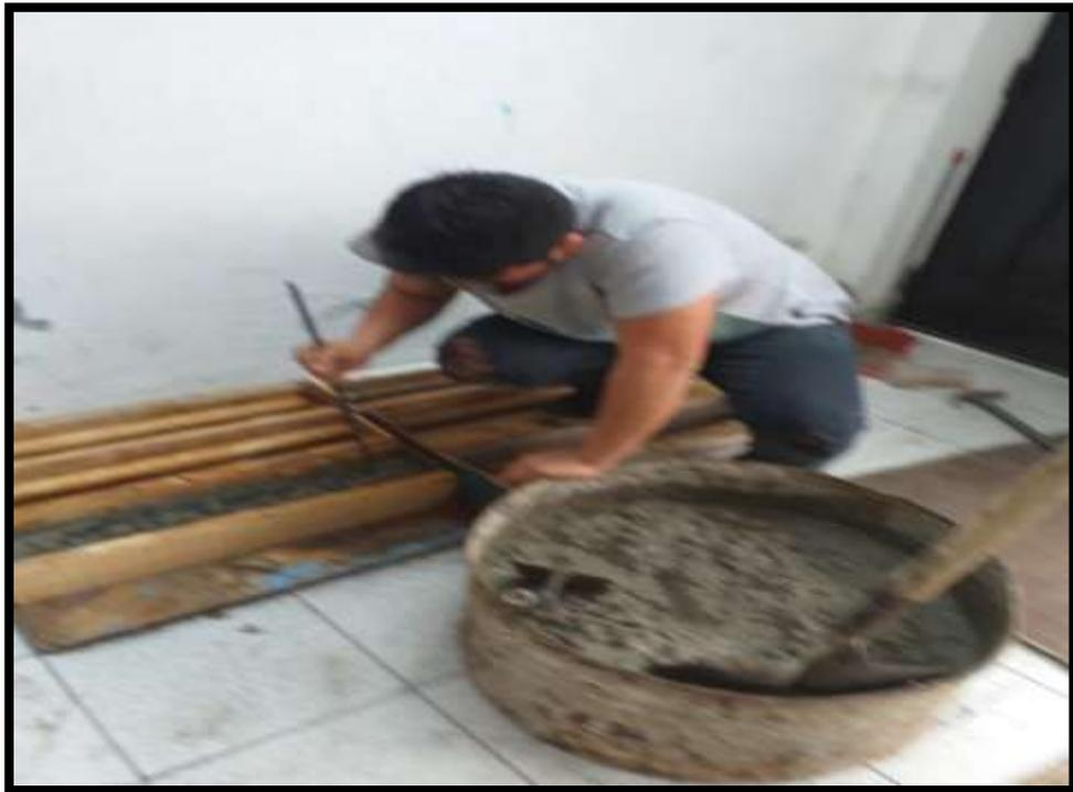
**Fotografía 04:** *Vibración del concreto con una varilla de acero.*
