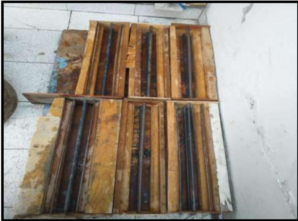
**Fotografía 02:** *Colocación de los aceros y encofrado de las viguetas.*
