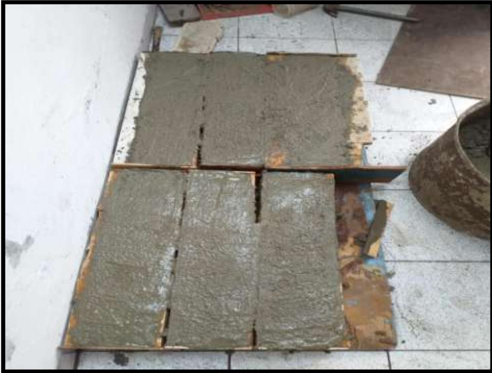
**Fotografía 05:** *Concreto en estado fresco en los moldes de la vigueta prefabricada.*
