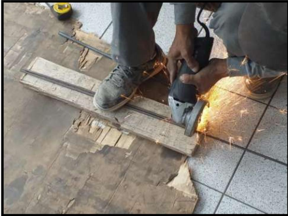
**Fotografía 01:** *Cortar los aceros para la vigueta de concreto in situ.*
