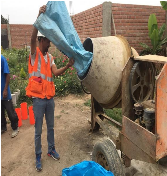
Mezcla de concreto en el trompo
