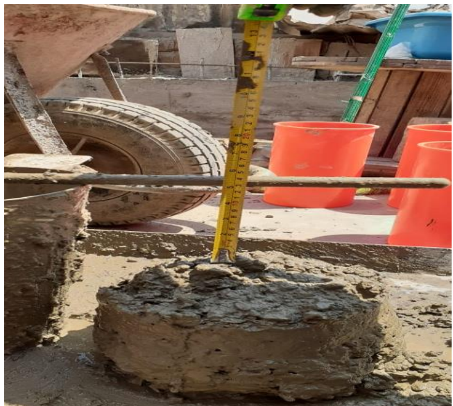
ensayo de asentamiento
