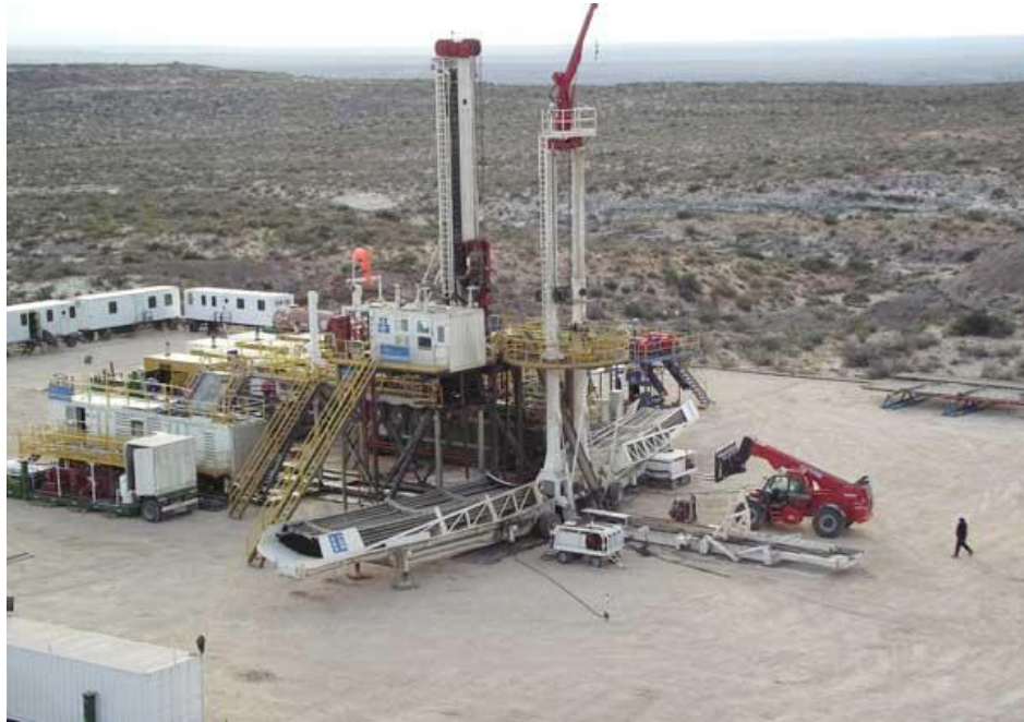
Figura 1- Equipo de perforación
