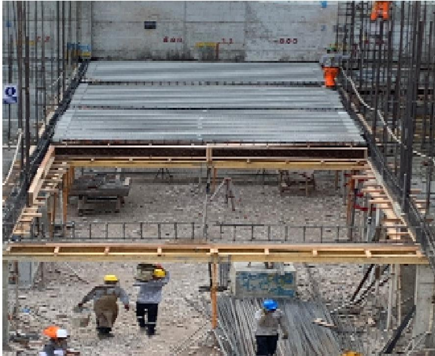
*Ilustración 13 Vista de encofrado y aplicación de vigueta - Fuente propia*
