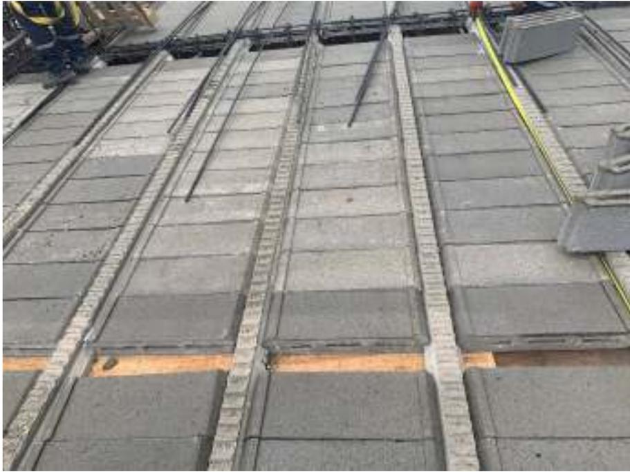
*Ilustración 15 Instalación de vigueta, bovedilla y acero negativo - Fuente propia*
