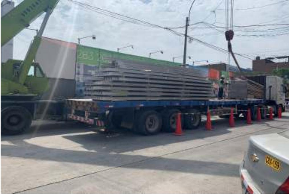
*Ilustración 11 Llegada de la vigueta pretensada y bovedilla - Fuente propia*
