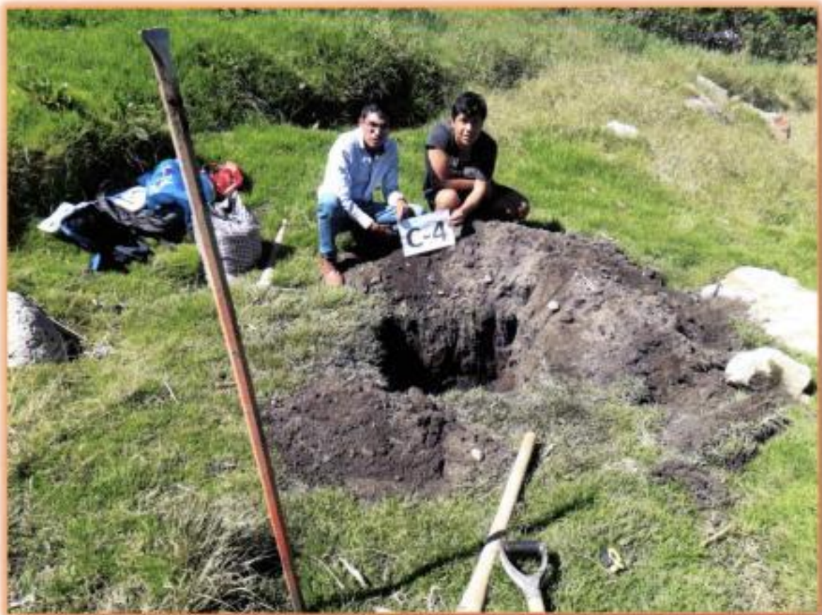
Foto N° 4: Vista panorámica de la Calicata C-4 (Línea de aducción y Red de Distribución)
