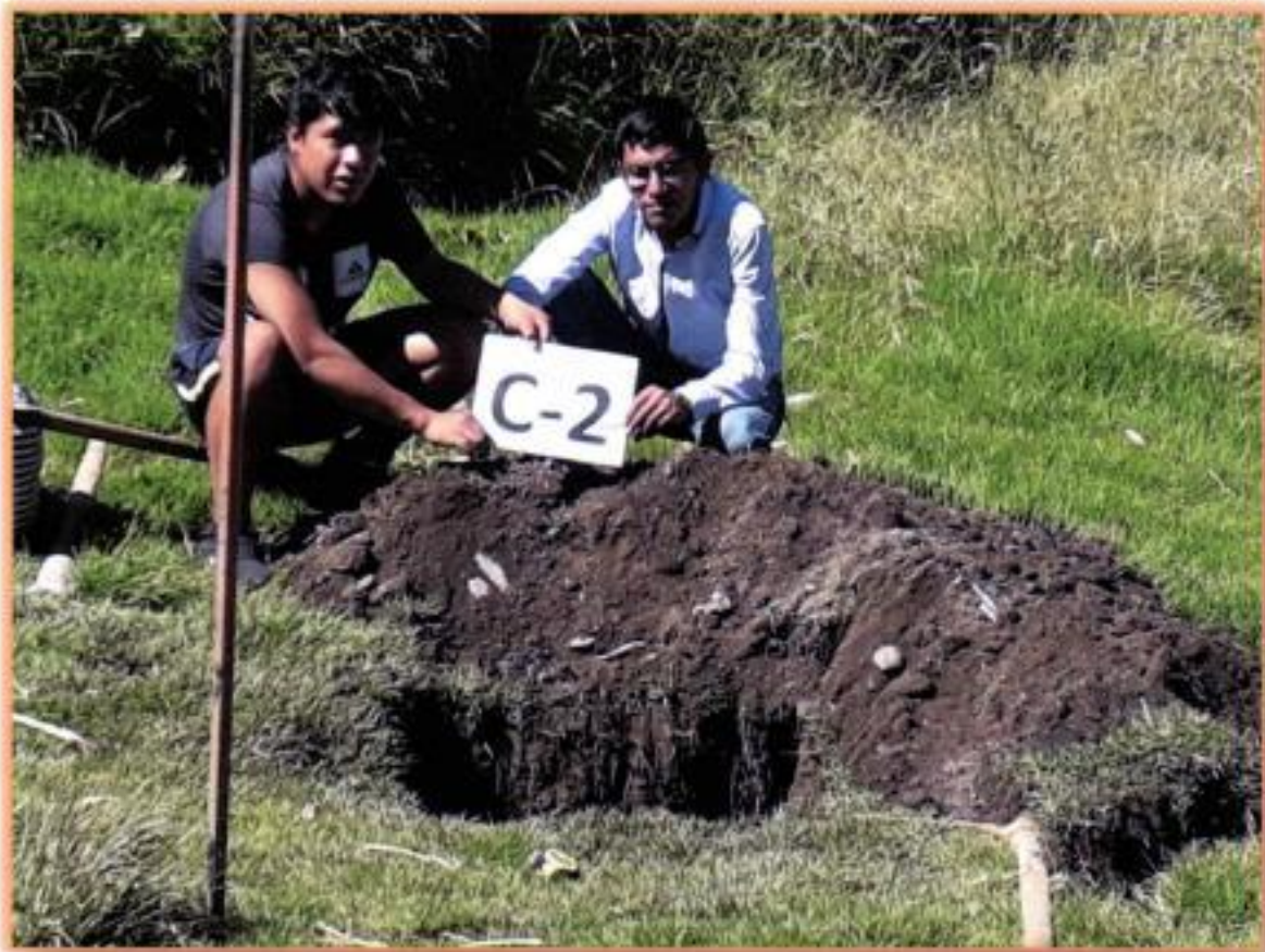
Foto N° 2: Vista panorámica de la Calicata C-2 (Línea de Conducción)
