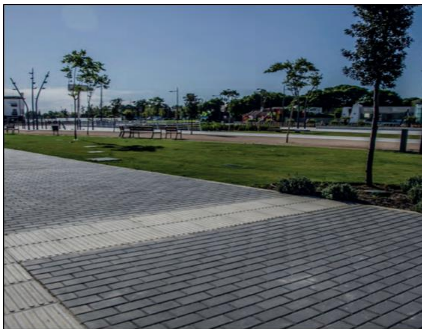
Figura 2. Modelo rectangular de adoquines pre fabricados.
