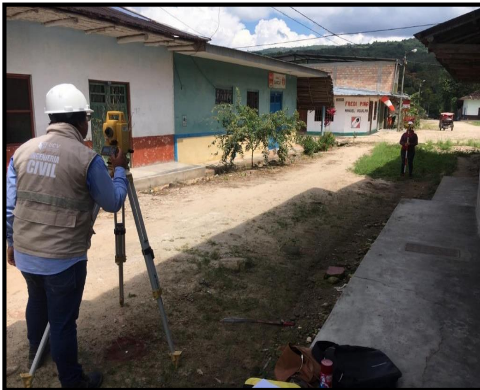
(foto N° 4) En la imagen podemos apreciar el levantamiento del sector la bajada ya para llegar al 4 punto que se encuentra en la plaza parte baja en la Localidad de San Antonio .
