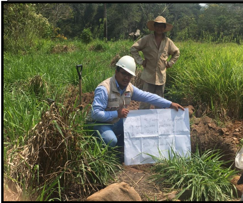
(foto N° 3) En la imagen podemos apreciar la culminación dl término de la excavación de la calicata.
