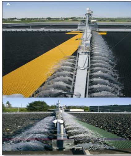
Figura 11. Filtros percoladores utilizando (A) plásticos (B) rocas como medio de soporte.
