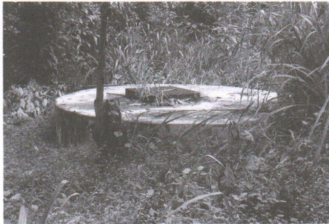
FOTO N° 02: ESTRUCTURA DEL TANQUE IMHOFFS EN UNO DE LOS PREDIOS DEL DISTRITO DEL SAN ANTONIO.
