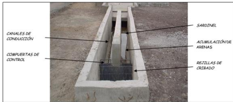
Figura 8. Rejillas, compuertas de control, canales de conducción, desarenadores y vertedor.
