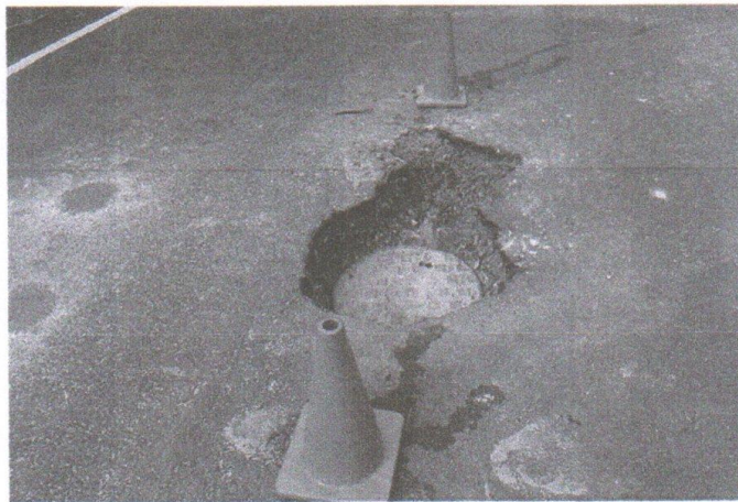
FOTO N° 06: REPARACION DE BUZON DE DESAGUE COLAPSADO EN UNO DE CALLES DEL DISTRITO.
