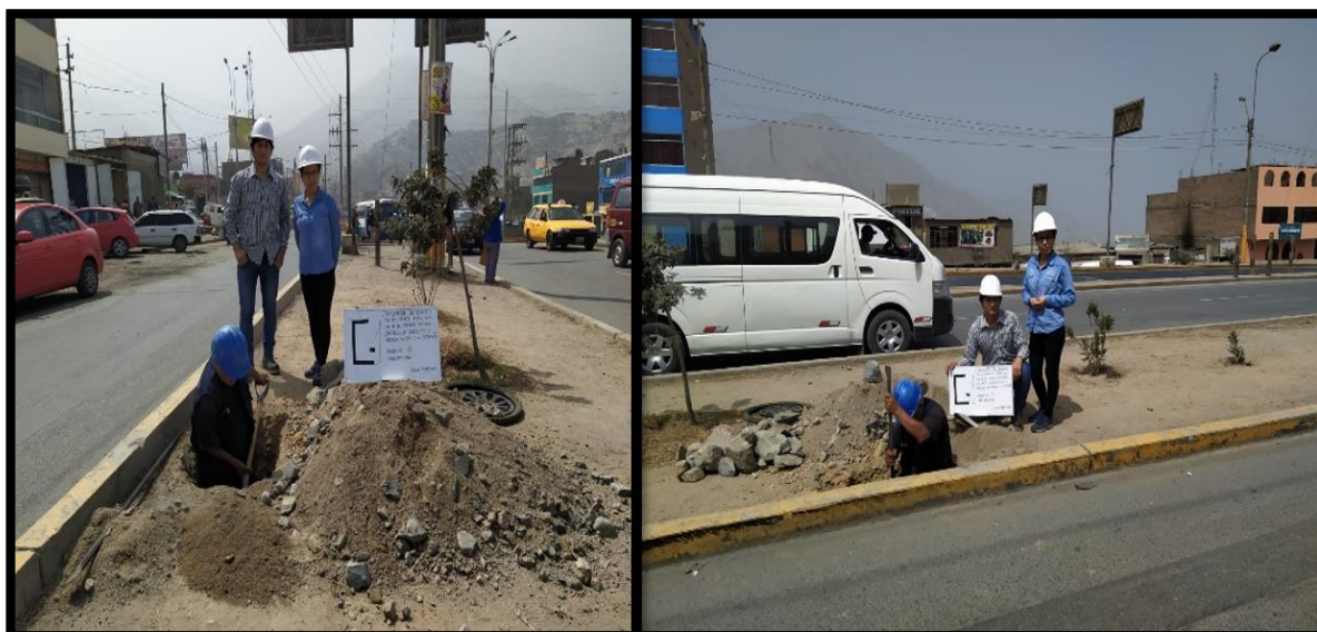
Figura 14: Realización de calicatas para la obtención de las muestras.
