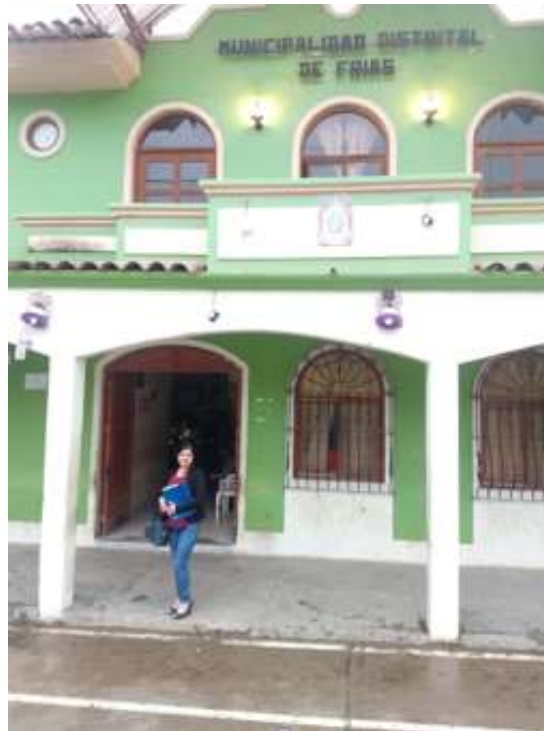
Ilustración 1. Municipalidad Distrital de Frías
