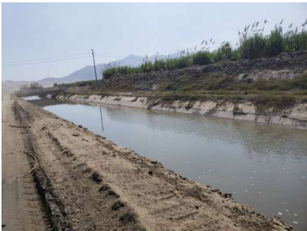
Figura 2: Canal Huaca Nepeña Progresiva 107 – 108, Chinecas.
