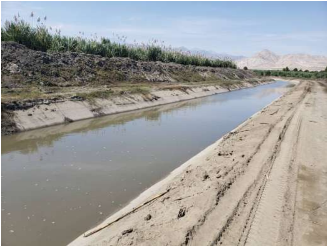
Figura 1: Canal Huaca Nepeña Progresiva 107 – 108, Chinecas.
