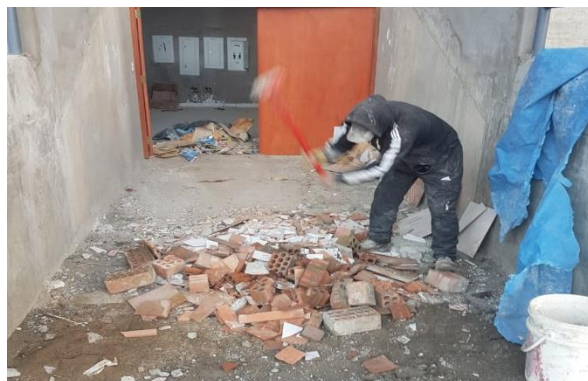
Figura 8: triturado de los residuos de construcción y demolición.
