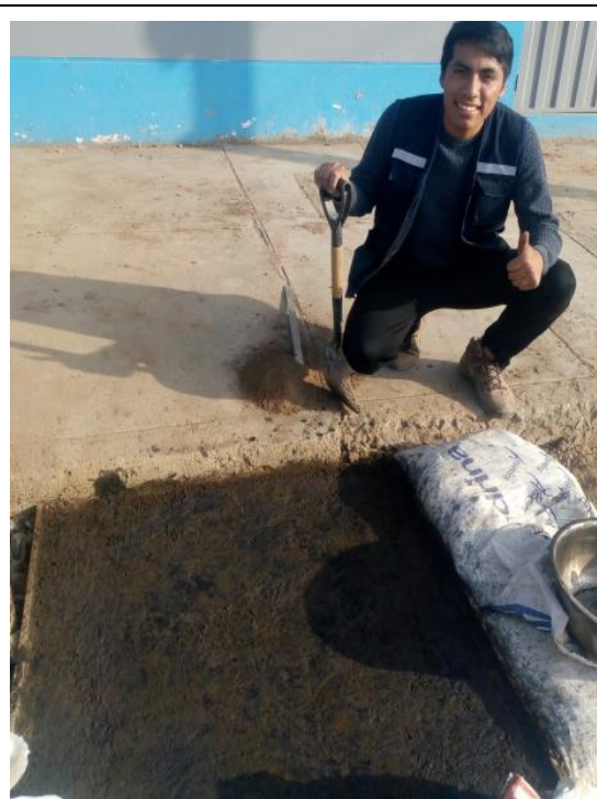
Simulación de Pavimentación con AggreBind - sellado superficial con AggreBin.
