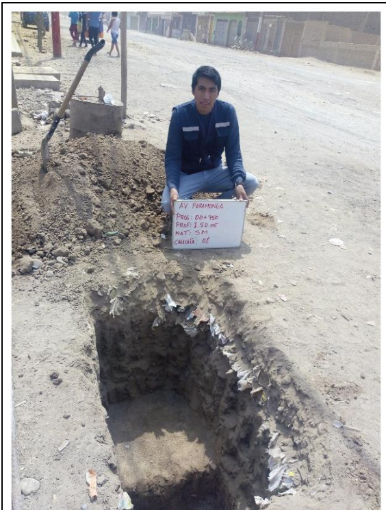
Calicata 01 : Hasta 1.50m de profundidad presenta suelo de un solo extracto de clasificación SUCS - SC-SM y se encontró desmonte hasta el nivel -0.20 m.
