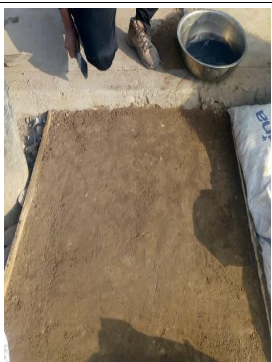
Simulación de Pavimentación con AggreBind – Estabilización del suelo con el AggreBind
