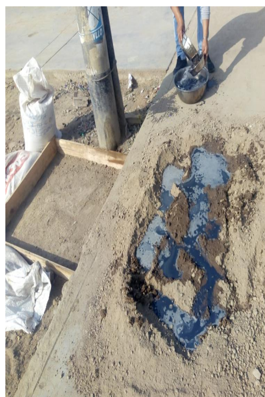
Simulación de Pavimentación con AggreBind – Proceso de mezclado homogéneo del suelo con el AggreBind.
