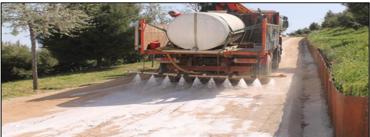
Figura 5. Estabilización Químico del Suelo
