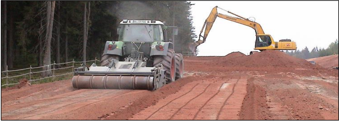
Figura 4. Estabilización Mecánico del Suelo
