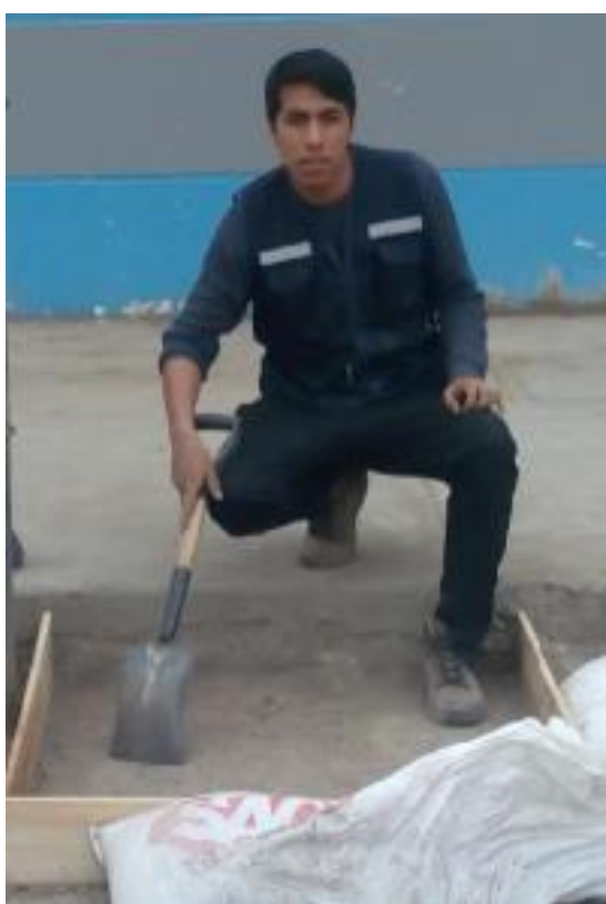
Simulación de Pavimentación con AggreBind - preparación del suelo a pavimentar.
