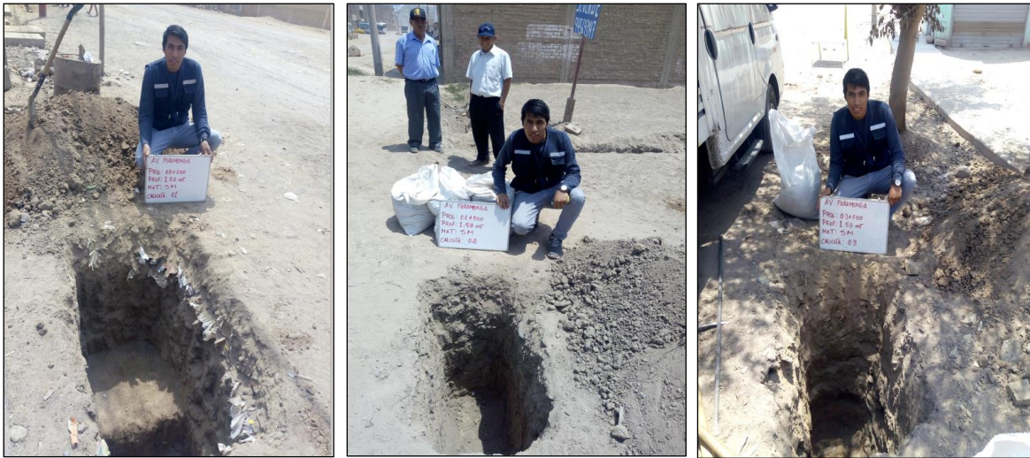
Figura 7. Extracción de Muestras de calicatas de 1.5 m de profundidad
