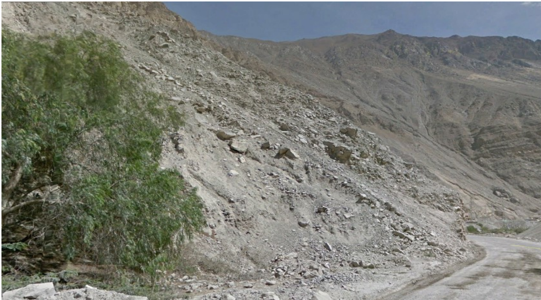
Foto 1. Fotografía del Tramo 64+600 Carretera Sayan – Churín
