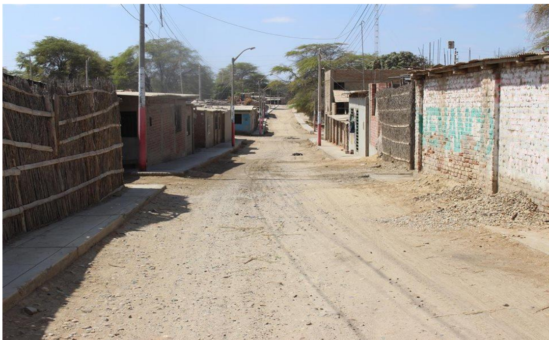
Asentamiento Humano laderas de Chillón Calle 41, distrito de Puente Piedra - Lima
