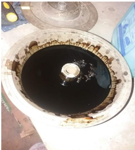
Material fresado desintegrándose el asfalto
