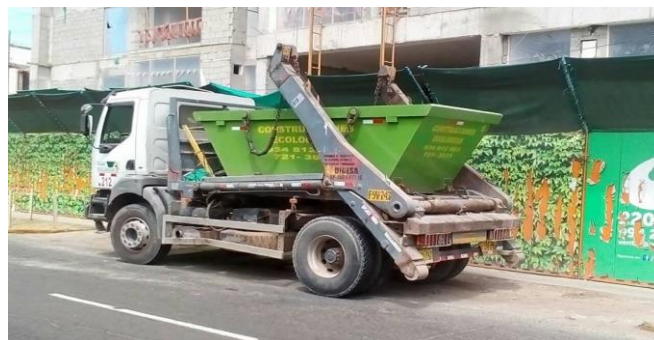
Figure 3 Traslado del material de demolición
