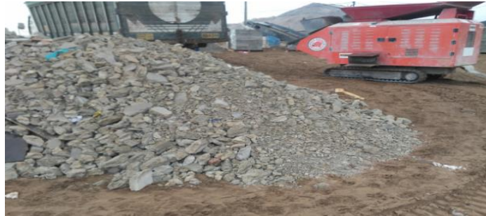
Figure 4 Trituración del material de demolición
