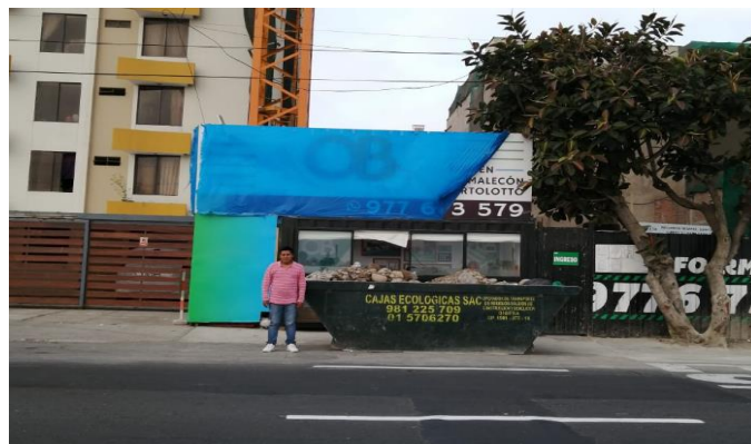
Figure 2 Acopio del material de demolición
