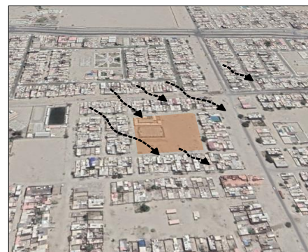
IMAGEN 8: Situación del terreno FUENTE: Elaboración propia
