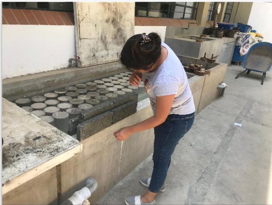
Figura 22. Armandu muro con bloquetas ecológicas
