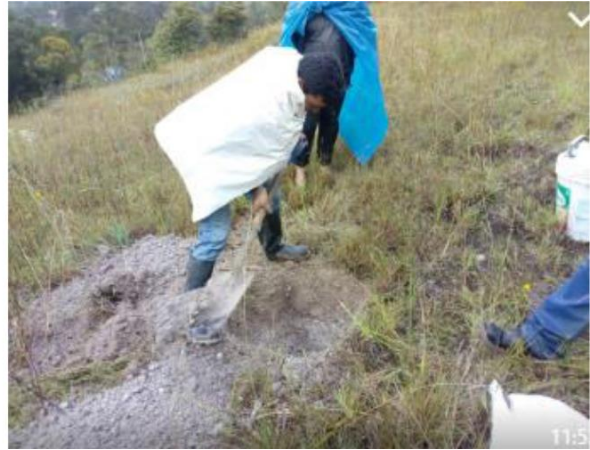
Iniciando excavación C-2
