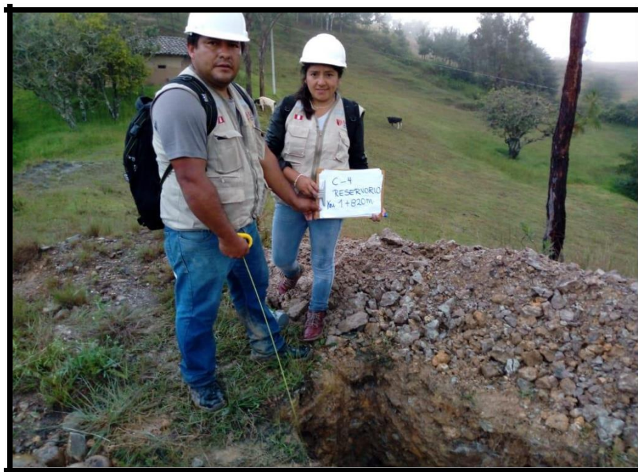
Ilustración. Excavación de la calicata 4-Reservorio.
