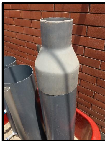
Figura 36. Colocación de reducciones de PVC
