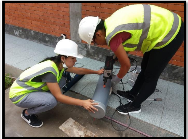
Figura 32. Perforación de la parte media de los tubos
