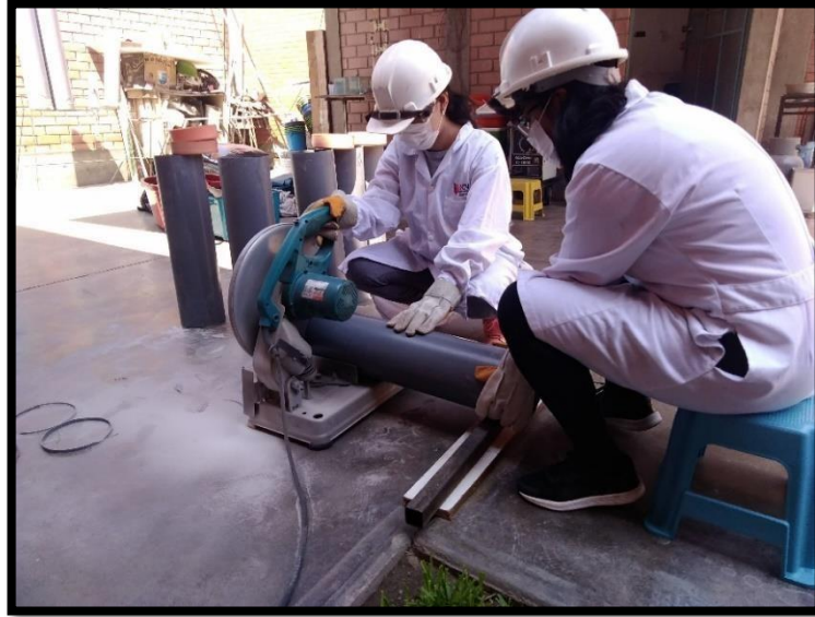
Figura 29. Corte de tubo de PVC haciendo uso de la tronzadora
