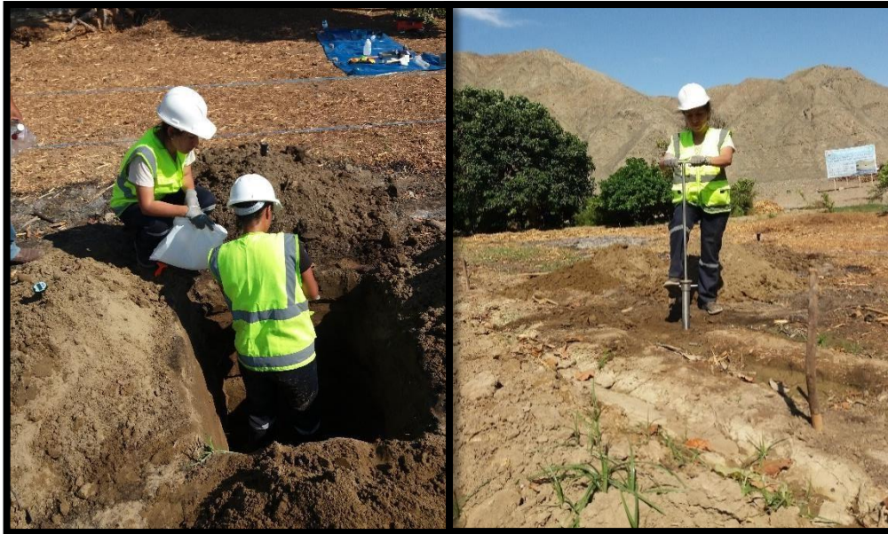
Figura 11. Excavación Calicata y Medición de Parámetros
