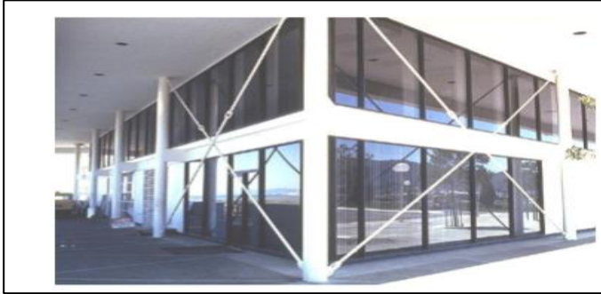
Figura 14: Arriostramiento en “X”
