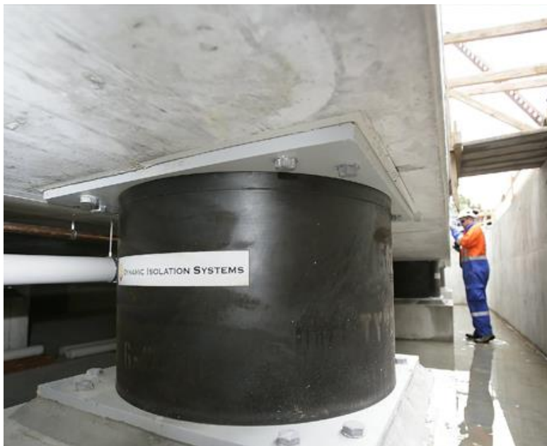
Figura 3. Aislador de goma de alto amortiguamiento
