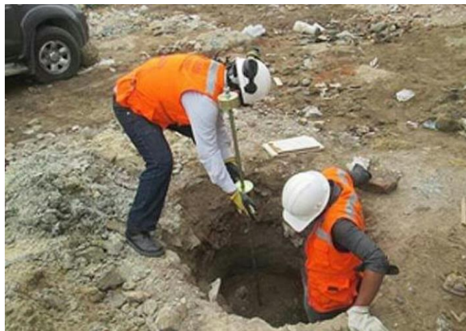
Ilustración 1. EXCAVACIÓN DE CALICATA
