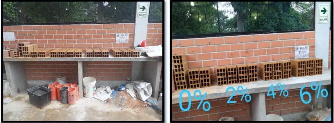
Fotografía N°37 y 38: Los ladrillos fabricados se coloca en un lugar seguro por separado, para realizar su secado al medio ambiente de acuerdo a la edad.
