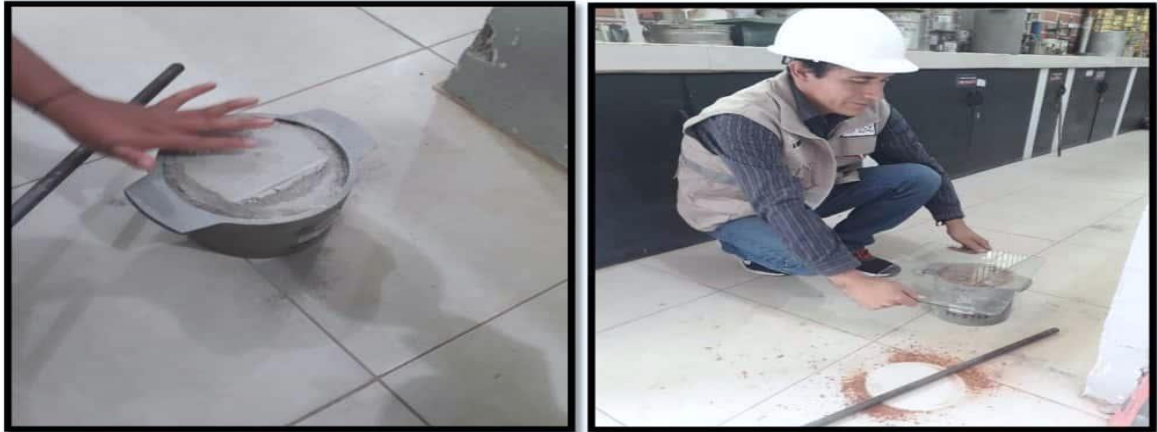
Fotografía N°5: Llenado del romerillo en capas.
