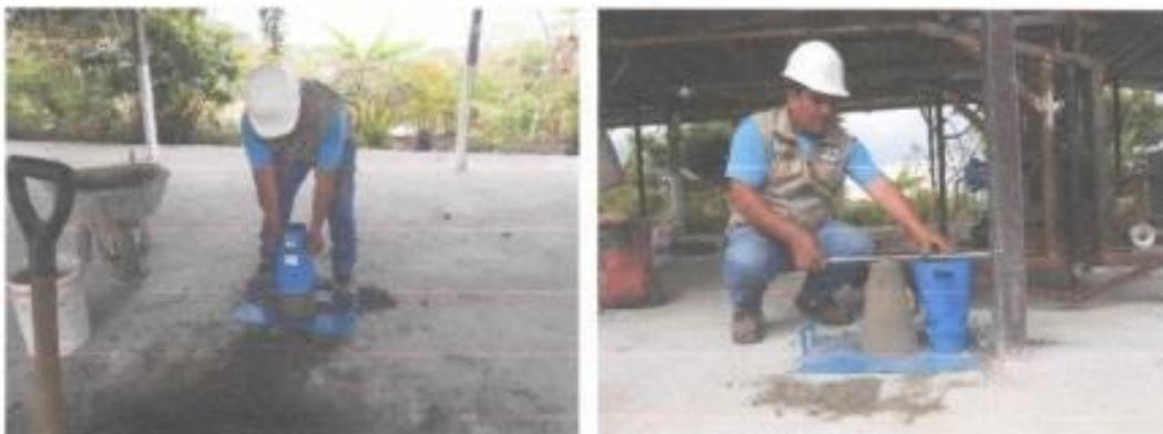
Figura N° 63 y 64: Colocación del concreto fresco en la máquina de vibro compactación. Moldeado de los bloques en la máquina de vibro compactación.
