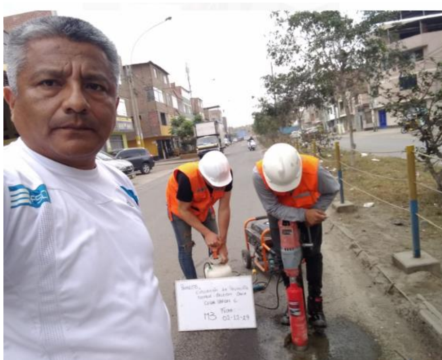
Fig 60. Extracción de testigos con utilización de grupo electrógeno
