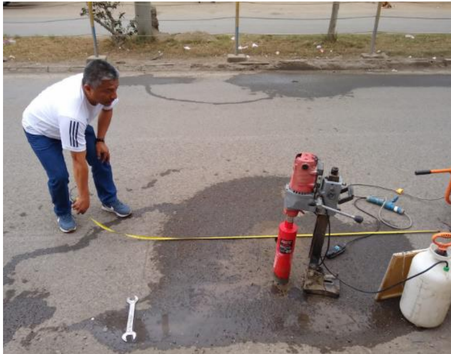
Fig 59. Extracción de testigos
