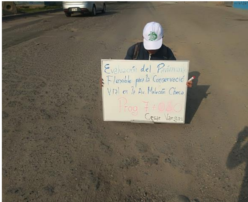
Figura 17. Progresiva 7+080, falla de huecos
