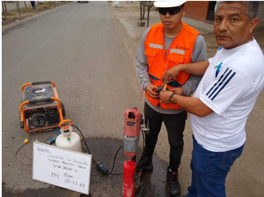
Figura 61. Extracción de 3 testigos para el estudio del pavimento
