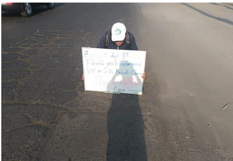
Figura 30. Progresiva 6+690, falla de piel de cocodrilo y grietas de borde
