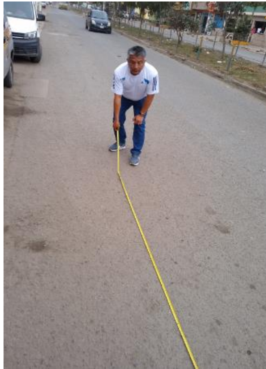
Figura 19. Progresiva 7+020, hueco y desprendimiento de material
