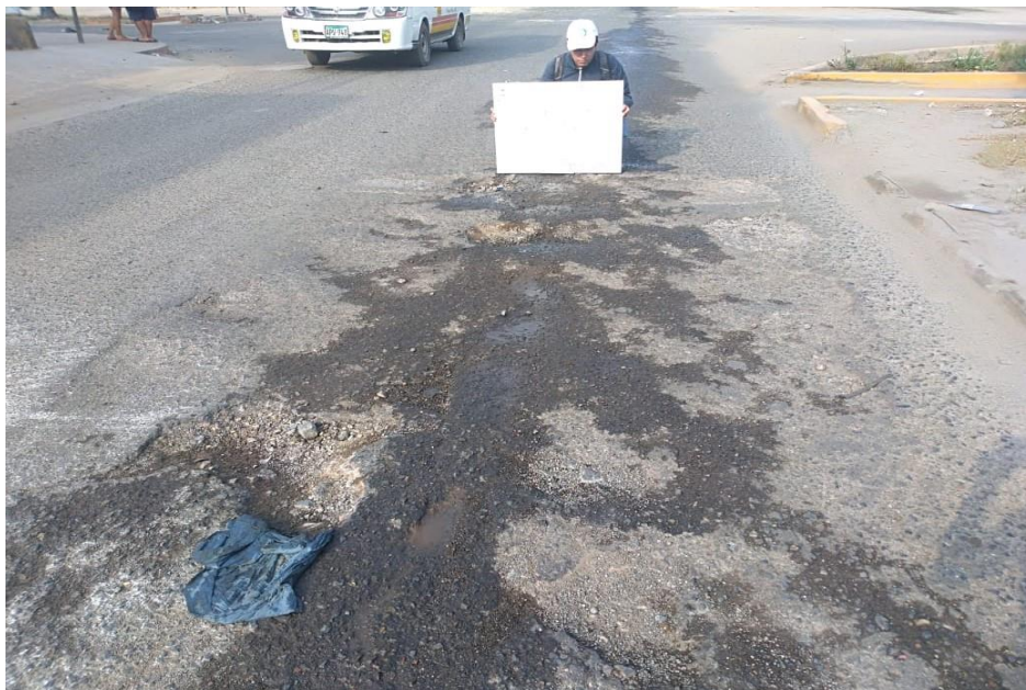
Figura 12. Final de progresiva de estudio 6+600
