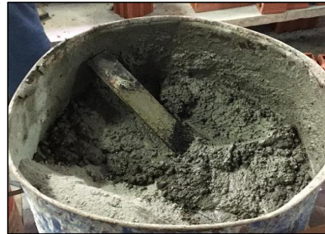
Figura 60. Preparación del mortero
