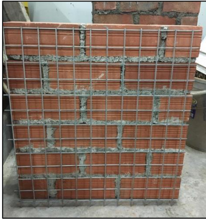
Figura 72. Refuerzo de murete tubular
