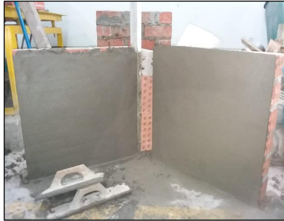
Figura 73. Tarrajeo de murete reforzado
