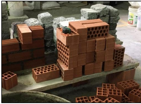
Figura 59. Unidades de albañilería humedecidas
