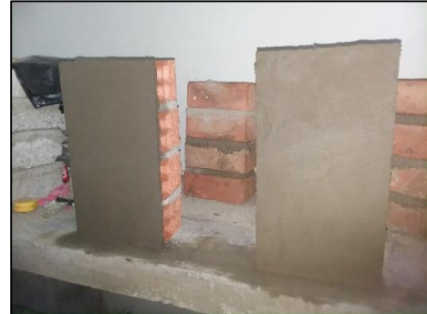
Figura 52. Tarrajeo de las pilas reforzadas
