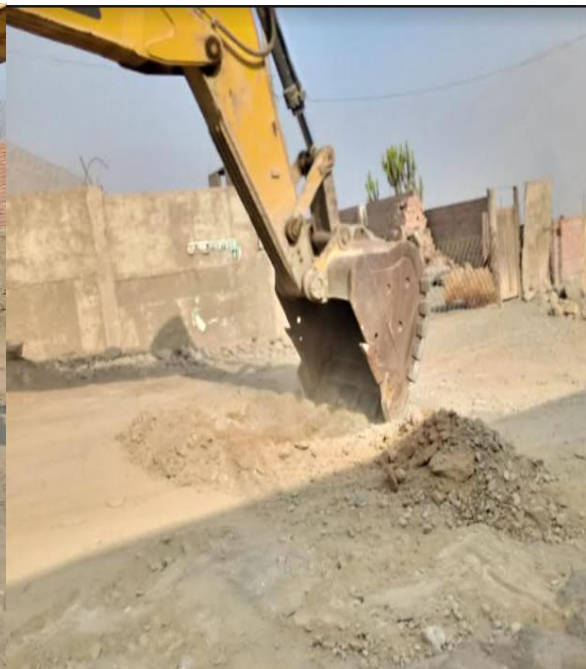
Punto de Calicata 02
