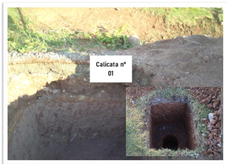
Imagen N° 17: Calicata lista para extracción.
