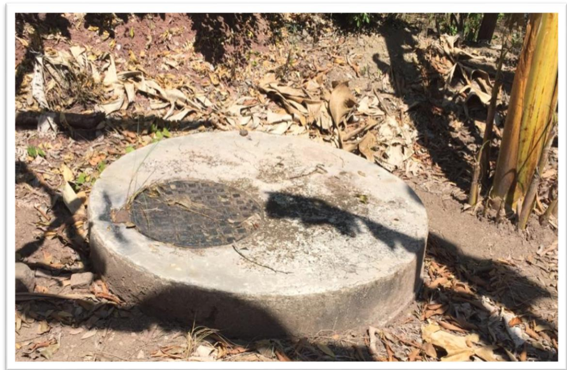
Imagen N° 12: Buzón ultimo para posterior se ponga a disposición final.
