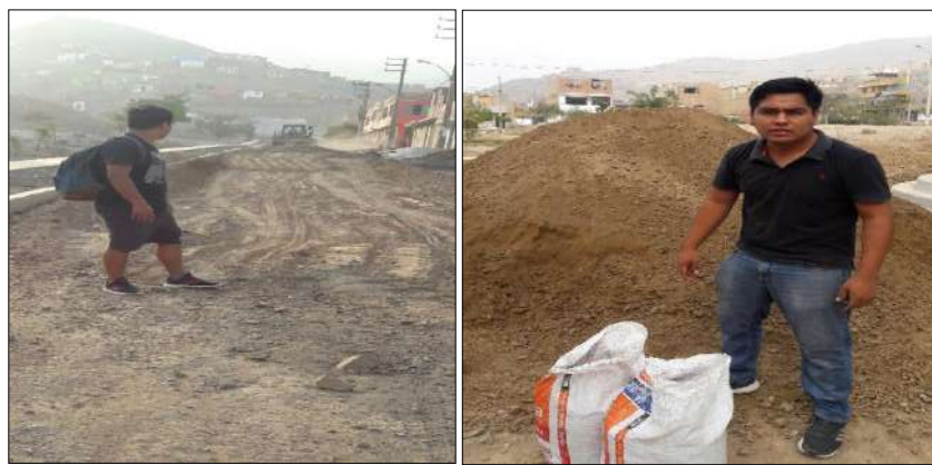
Figura 15. Material de afirmado cantera la Campana en obra
