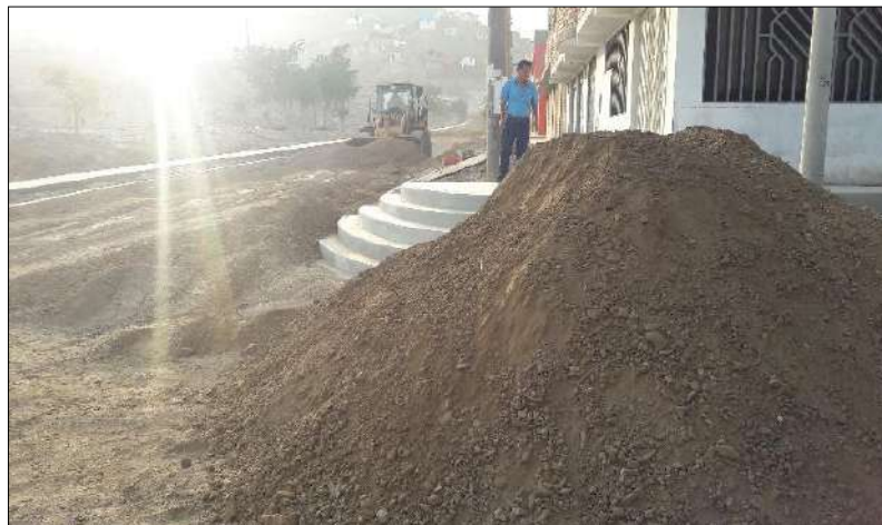
Figura 2. Material de afirmado cantera la Campana
