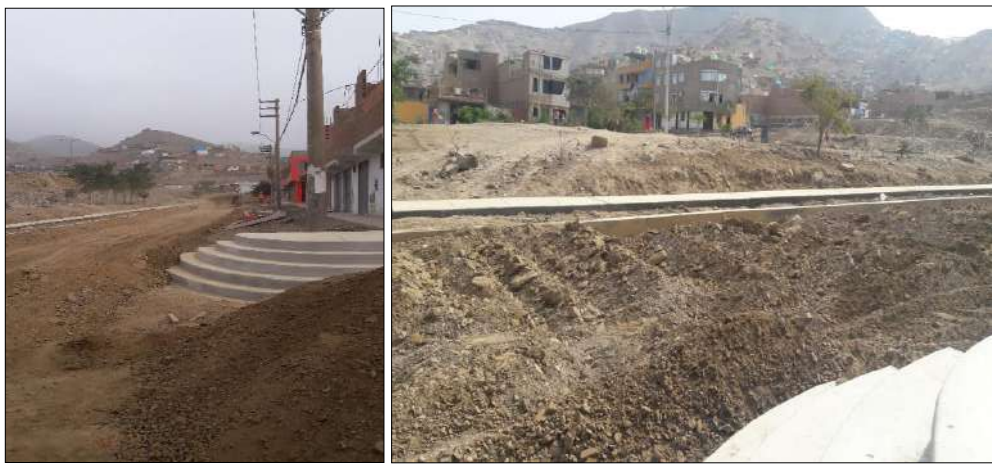
Figura 20. Pavimentación en Jardines de Shangrila
