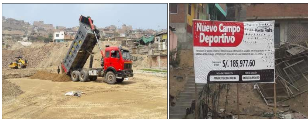
Figura 24. Uso del afirmado de la cantera la Campana en obras
