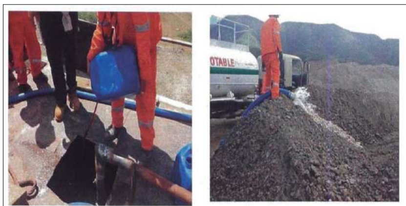
Figura 5. Combinación suelo – TerraSil por vía húmeda
