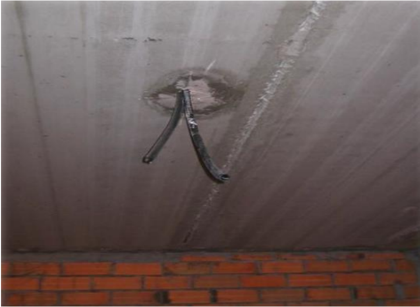
Imagen 12. Acabado final Instalaciones eléctricas
