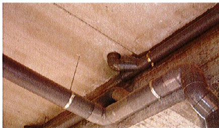
Detalle N°4: Hueco para paso de las instalaciones sanitarias.
