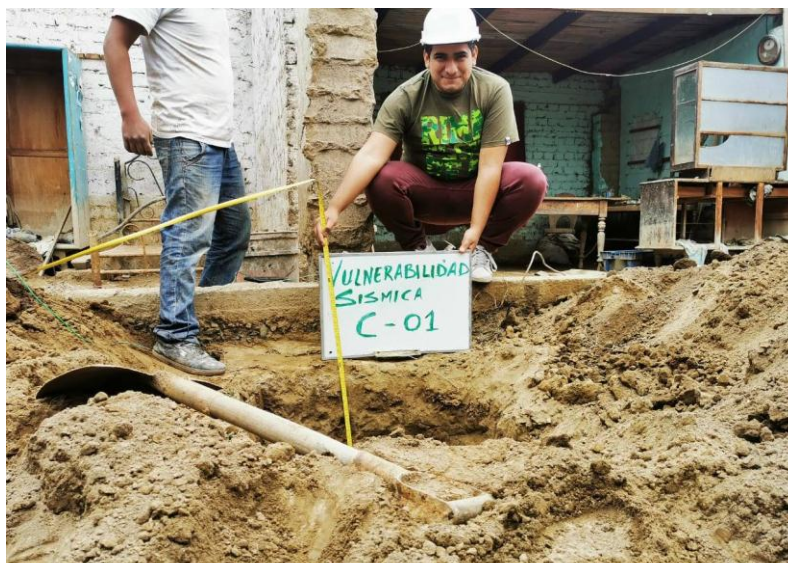
Figura 27: Medición de la excavación de la calicata N° 1
