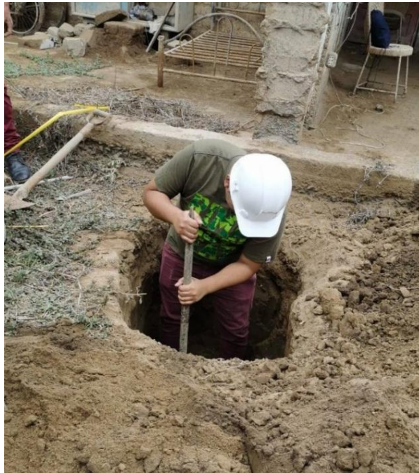
Figura 26: Excavación de la calicata N° 1
