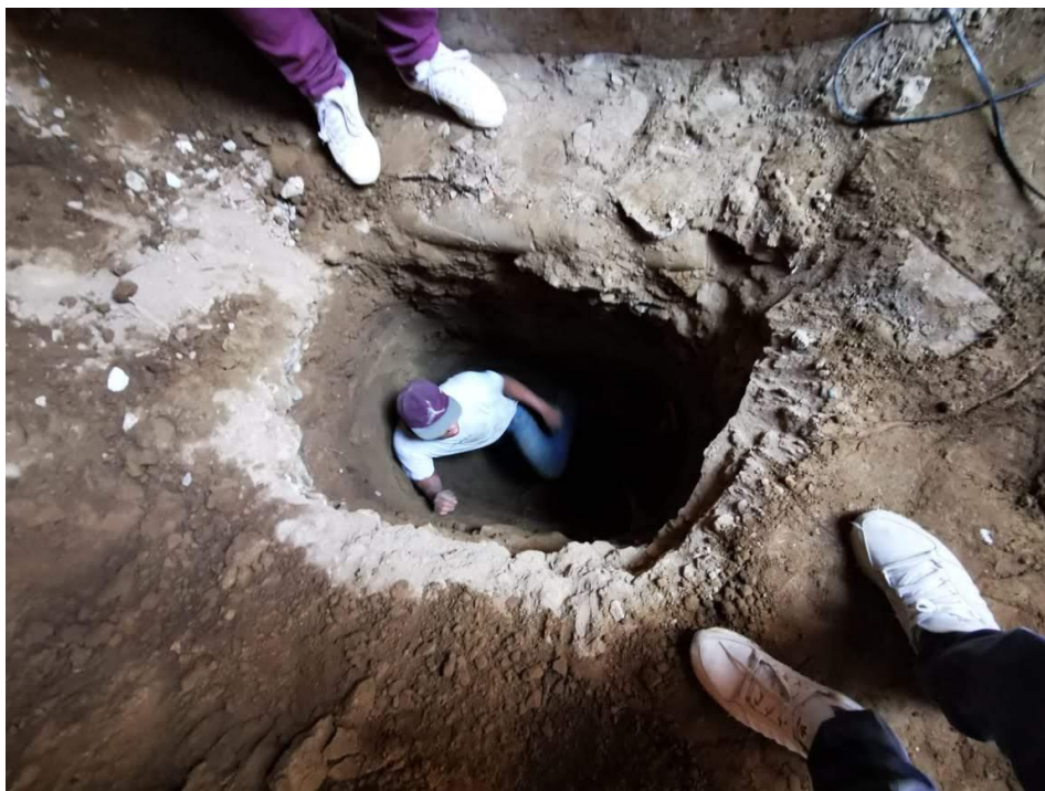
Figura 30: Medición de excavación de calicata N° 2
