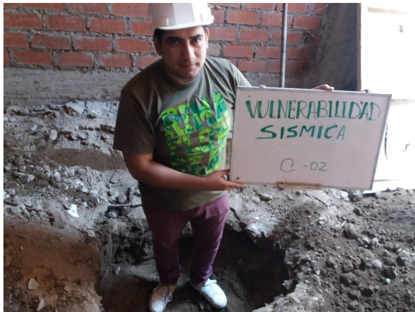
Figura 29: Excavación de calicata N° 2
