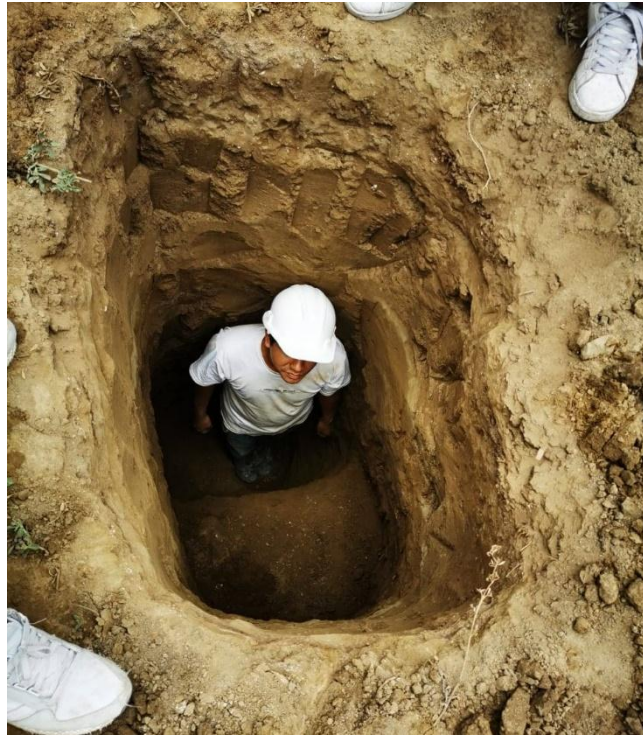
Figura 28: Calicata N°1 a 3m de profundidad
