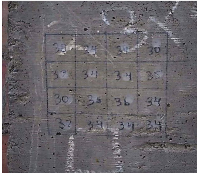
Figura 48: Datos de prueba de esclerómetro en columna
