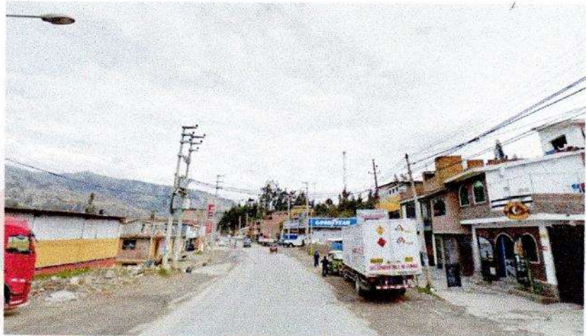
Vista fotográfica panorámica de Sur a Norte; características técnicas de la vía carretera Huaraz – Caraz - Cascapampa.
