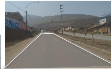
2 AV. NORTE SUR VIA COLECTORA
