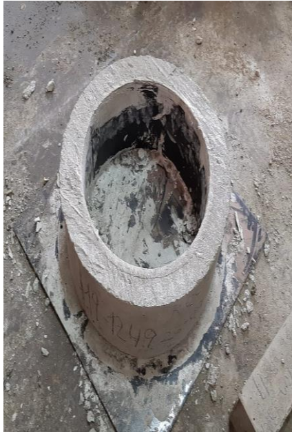
Vaciado de anillos de concreto
