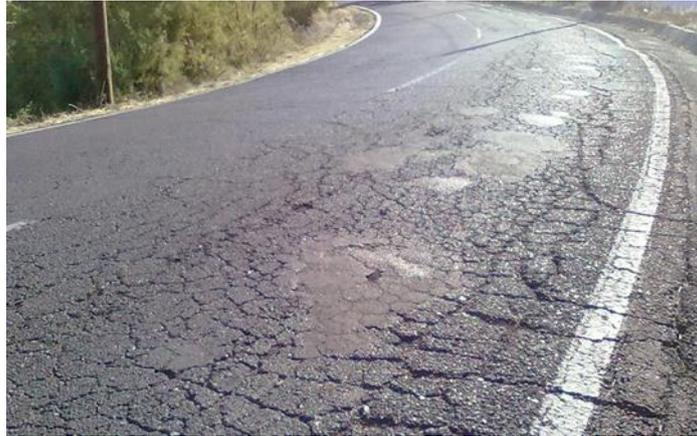
**Figura 2:** Falla de pavimento flexible por mala estabilización
