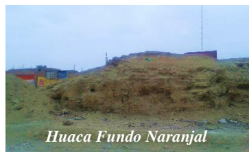
Fuente: Levantamiento Fotográfico Elaboracion: Propia
