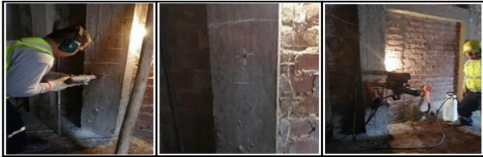
Figura 20. Colocación de perforadora industrial
