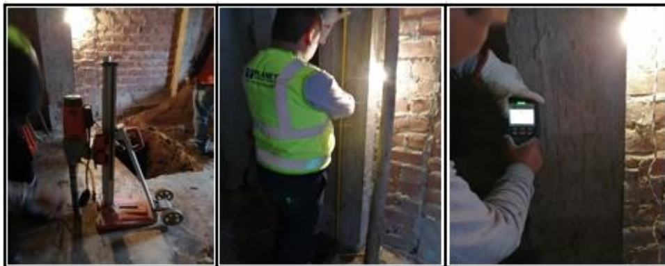
Figura 19. Identificación de vigas y columnas
