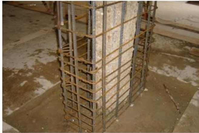
Figura 4. Encamisado de una columna de concreto armado
