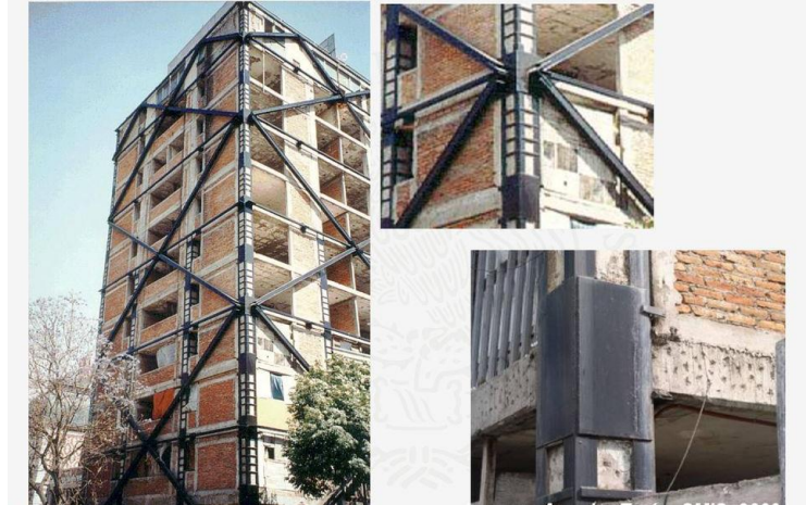
Figura 7. Platinas metálicas para columnas
