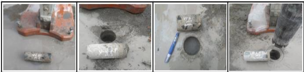
Figura 22. Extracción de muestras de vigas
