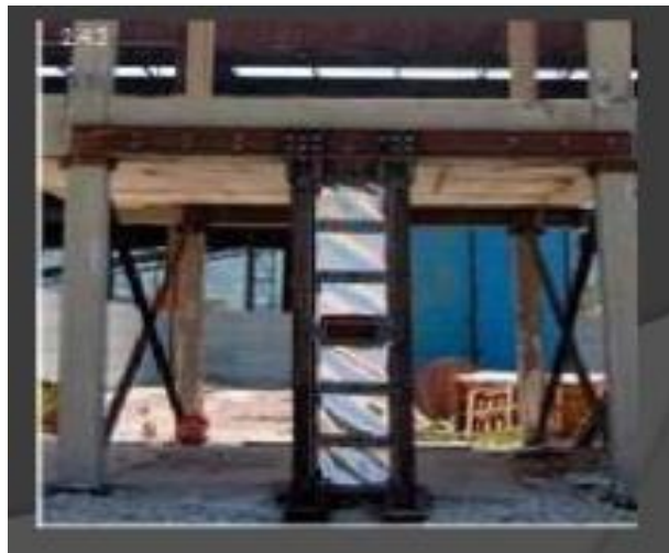
Figura 8. Platinas metálicas para columnas
