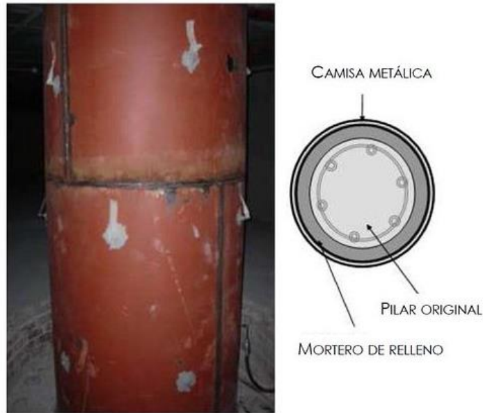
Figura 6. Encamisado Metálico
