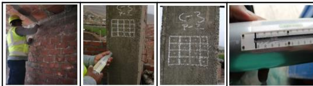
Figura 24. Procedimiento del Ensayo de Esclerómetro
