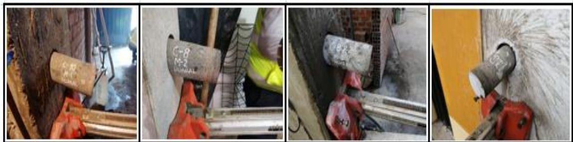
Figura 21. Extracción de muestras de columnas
