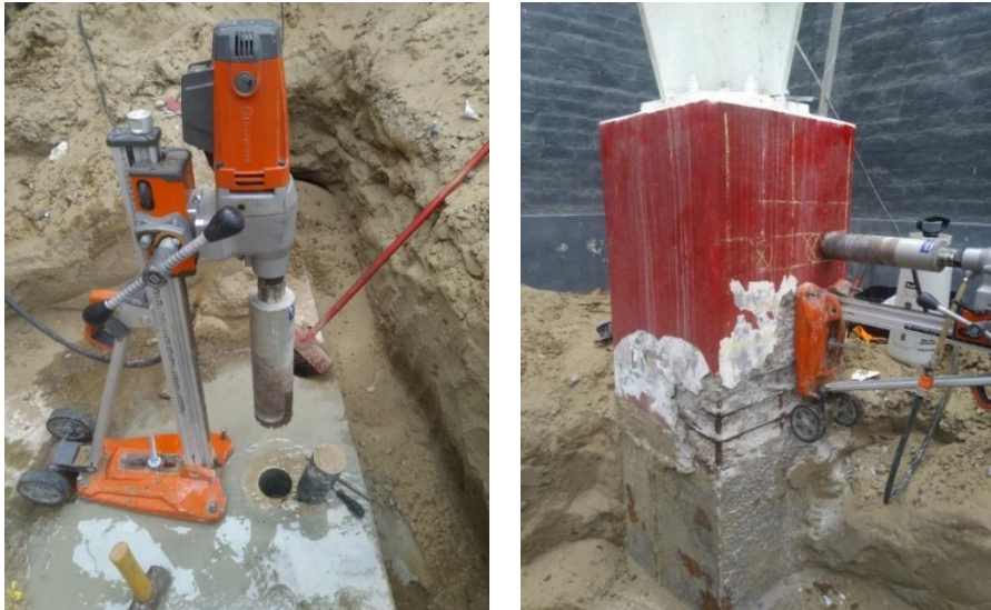
Figura 12. Extracción de Especímenes de concreto
