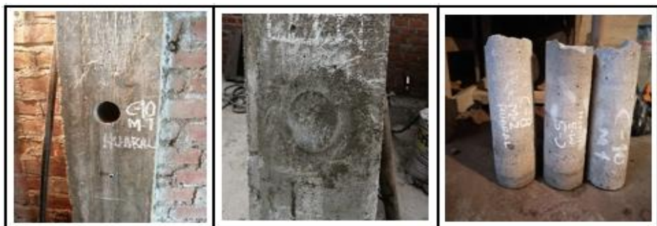
Figura 23. Tapado y muestras de la columnas y vigas
