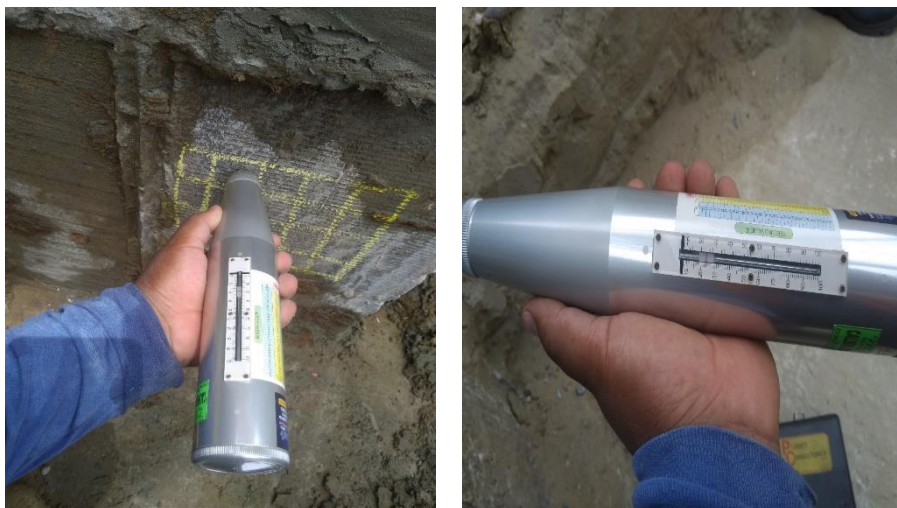
Figura 11. Ensayo con el Esclerómetro
