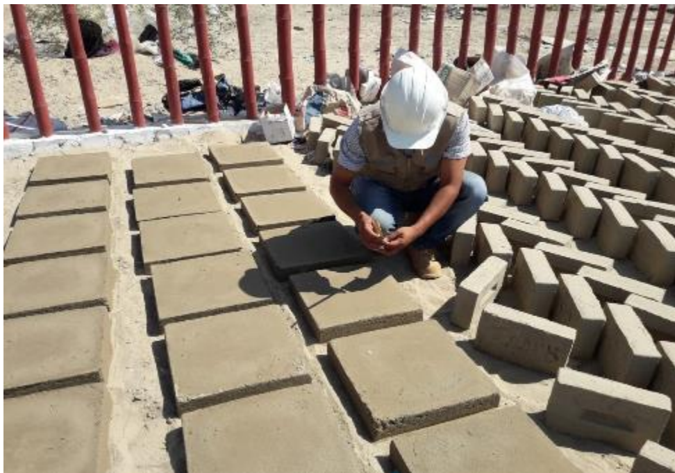
Fotografía 21: Supervisión del proceso de secado de los bloques de adobe
