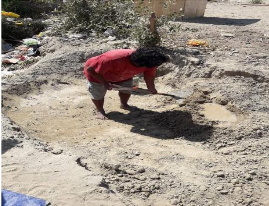
Fotografía 10: Preparación de barro para adobes
