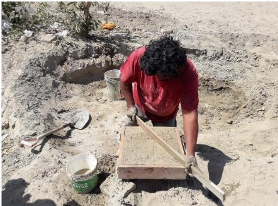
Fotografía 15: Nivelación del barro en la gavera
