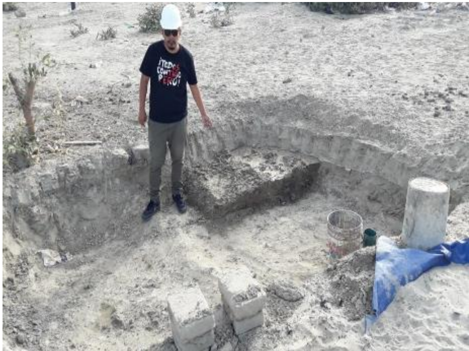
Fotografía 8: Cantera de tierra para preparación de adobes
