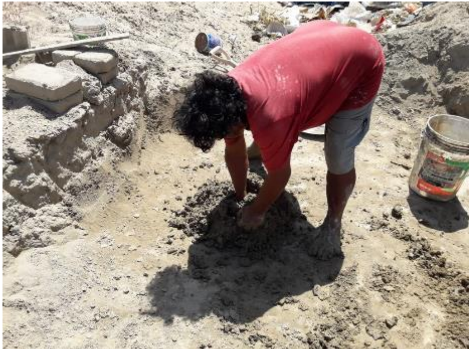
Fotografía 11: Incorporación de garbancillo
