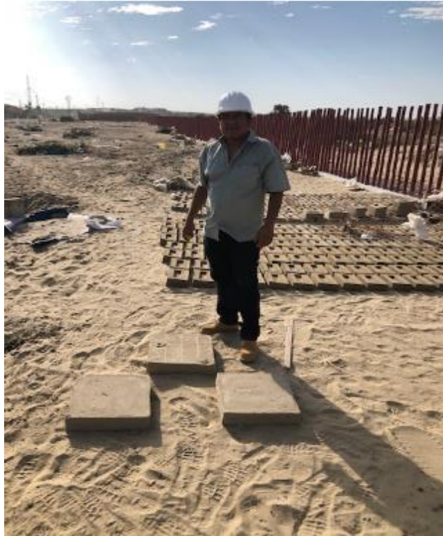
Fotografía 24: Preparación para prueba de resistencia en campo
