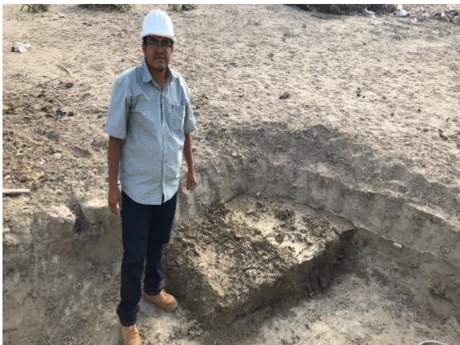
Fotografía 7: Cantera de tierra para preparación de adobes
