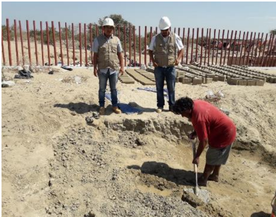
Fotografía 9 : Preparación de barro para adobes
