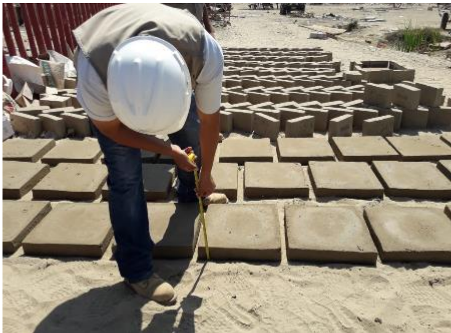
Fotografía 22: Medición de bloques de adobe durante el proceso de secado
