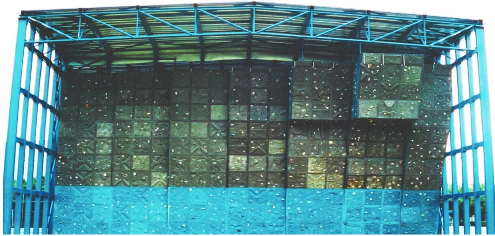
Figura 84. Foto de muro de escalar. Copyright 2017 por Ecoprojects. Reimpreso con permiso.
