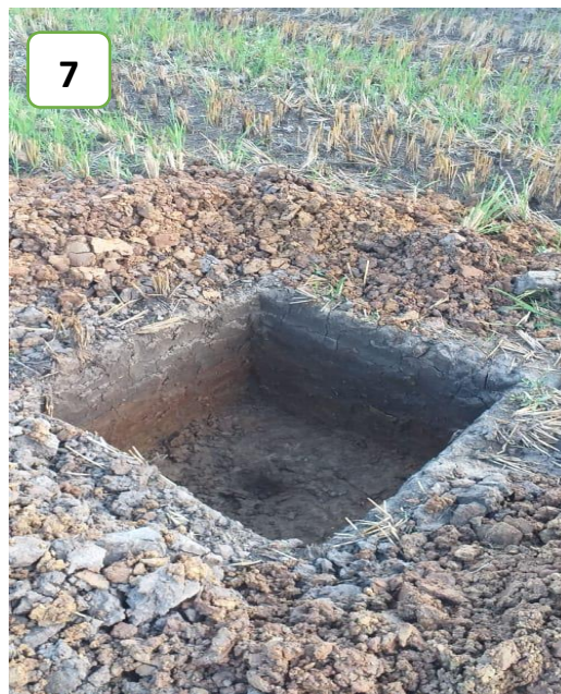
Imagen N° 7: Calicata para extracción de muestra de físico-químico del terreno.
